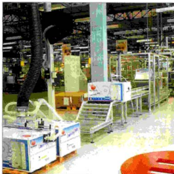
شکل ۳-۱۵ سیستم بسته بندی بویلرها
